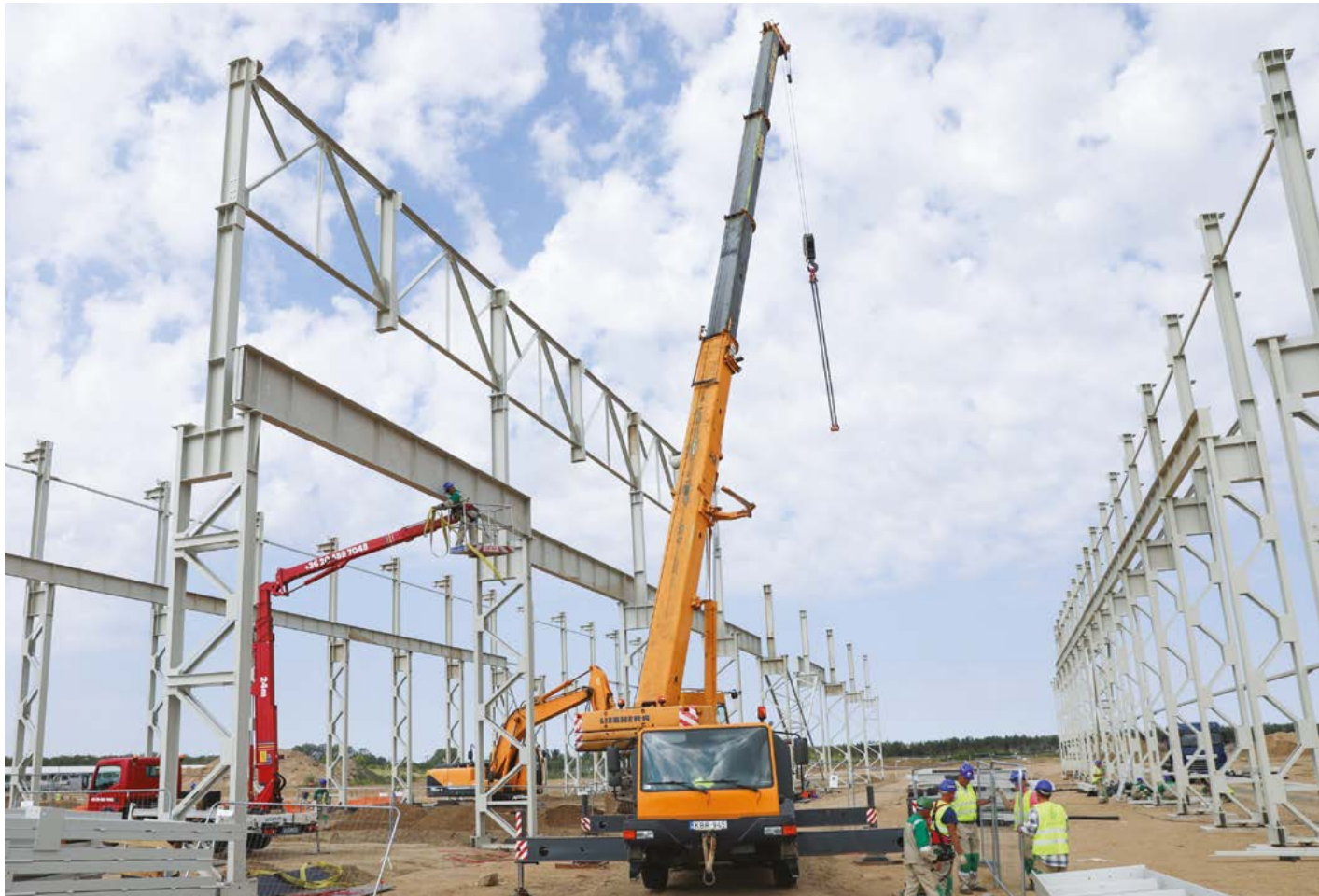
Épül az acél- és betonacél-összeszerelő üzem
